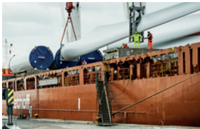
Der lastes vindmøllevinger fra kajen på Esbjerg Havn.
