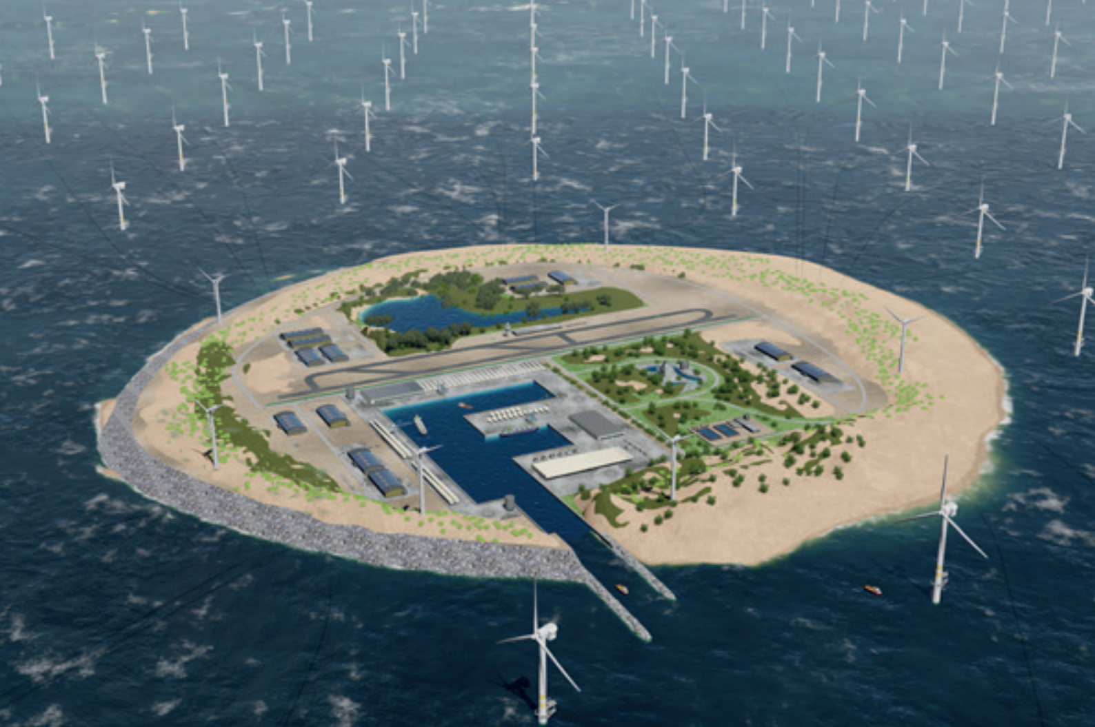
I 2017 indledte Energinet.dk og TenneT et samarbejde om 'North Sea Wind Power Hub' i Nordsøen. Projektet er stadig i de indledende faser, og der er endnu ikke taget beslutning om placering eller design. Billedet her er en illustration af, hvordan energiøen kunne se ud. Udarbejdet af TenneT.
